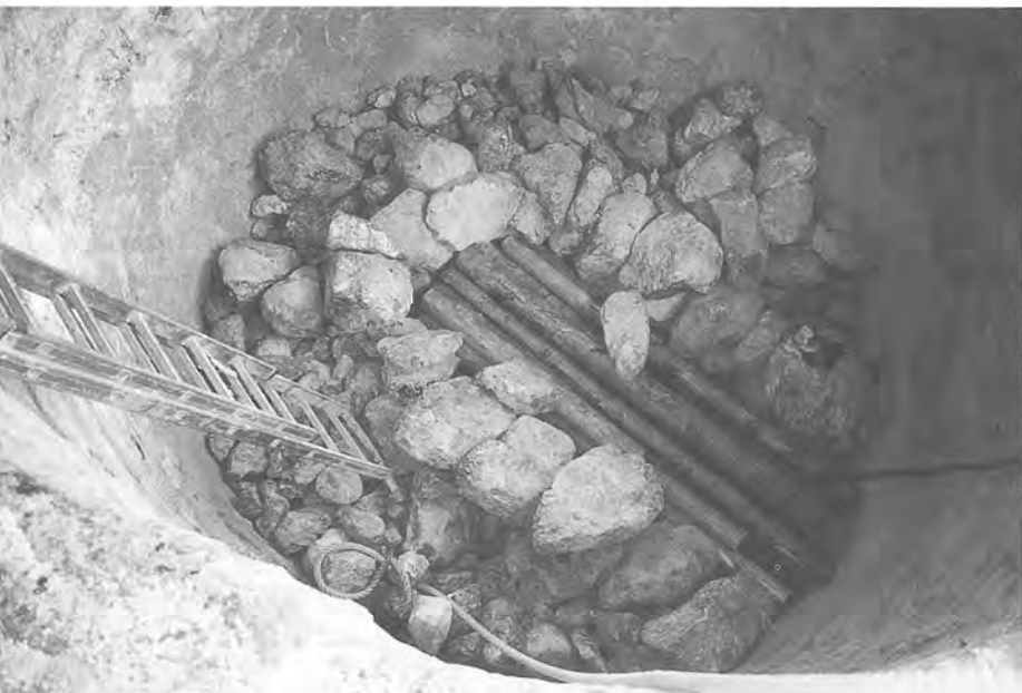
c) vue verticale sur le boisage destiné à soutenir la voûte
