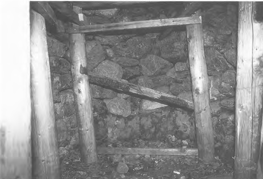
b) échafaudage de bois dressé à l'intérieur de la chambre de chauffe pour soutenir la voûte
